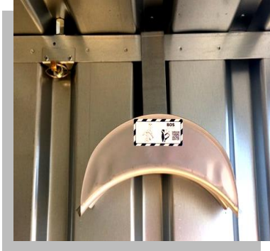
Schlauch- und Kabelaufhängung
