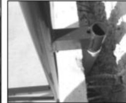
Bild 3 Stärke der Hohlwand-Schale beachten
