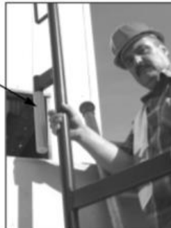
Bild 2 Konsole mit Kunststoffhülse und Stopfen
