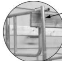
Bild 7 Quergeländer innenliegend gegenüber dem Geländerpfosten
