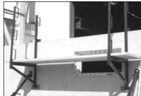
Bild 5 Auflegen der Bohlen
