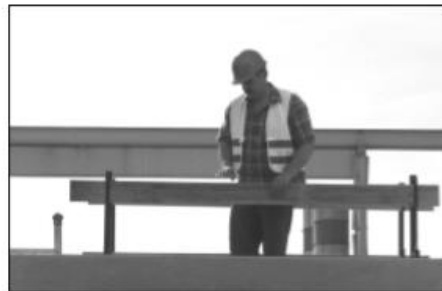
Bild 6 Seitenschutz nach vorne und nach hinten errichten
